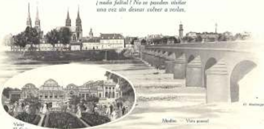
Vista El Causse
