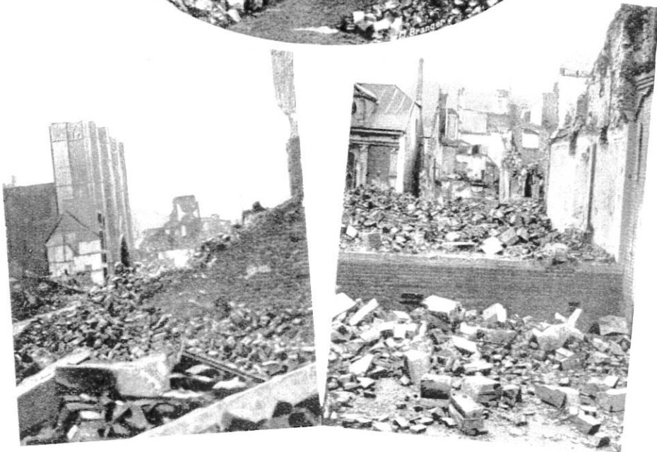
Quartier de Leffe, entièrement anéanti
