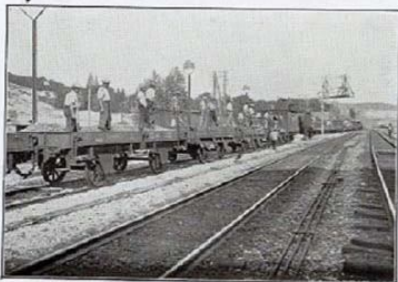
Ouvriers debout sur des wagons d'un train de service en marche
