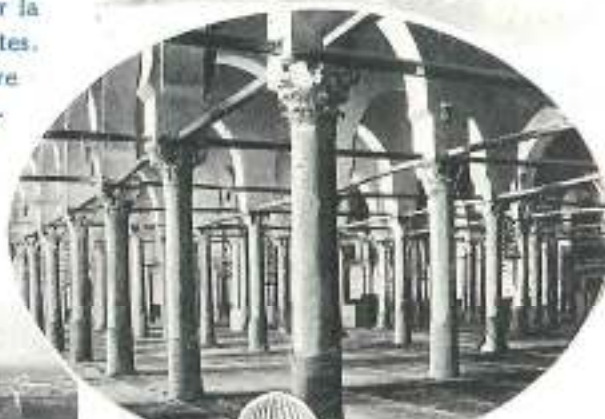
Kairouan, Intérieur de la Grande Mosquée
