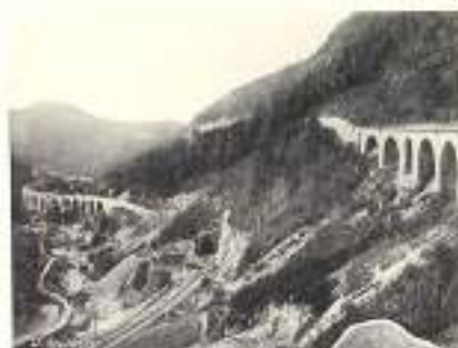
Morez — Viaduc de l'Évalade
