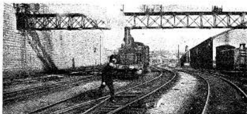
On doit enjamber les appareils des voies pour les franchir sans danger.
