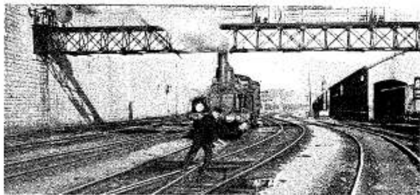
On risque d'avoir le pied coincé en le posant dans un appareil de voie pour le franchir.
