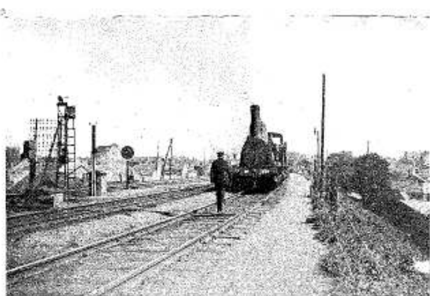
Il faut circuler sur la voie en sens inverse du mouvement des trains.
