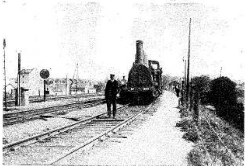
Ne pas circuler sur la voie en tournant le dos au train.
