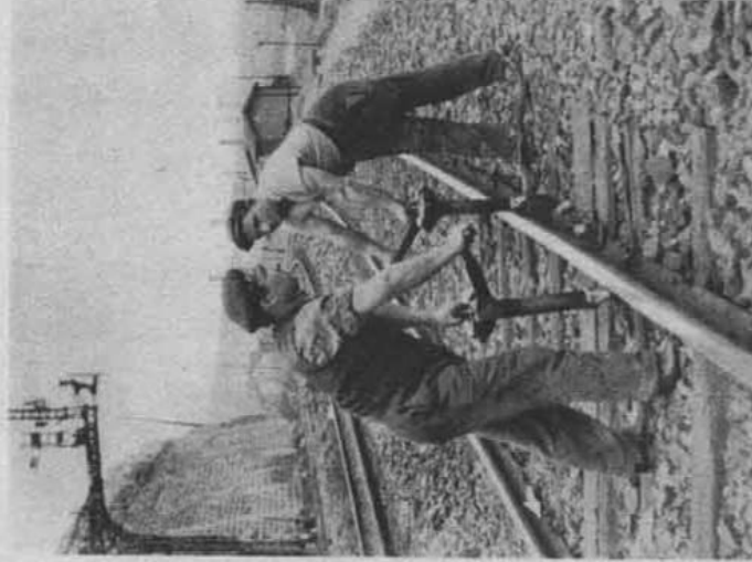
Fig. 15. Tirefonneuses agents «Limouzin» en service. (Les agents travaillent de part et d'autre du rail en se faisant face et en maintenant entre eux une distance de quelques traverses.)
