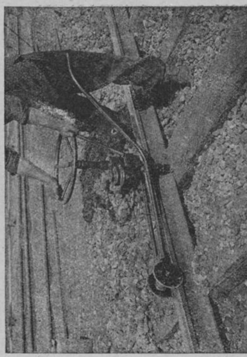
Tirefonneuses mécaniques à main. Plus de 250 sont actuellement en service en France.
