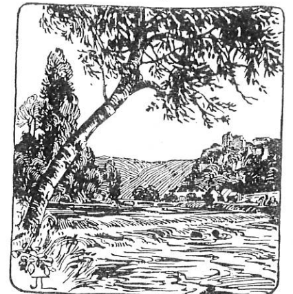
BESANÇON. BARRAGE DU DOUBS.
