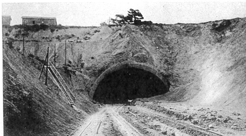
Tête nord du souterrain du Rove au débouché dans la tranchée de Gignac (Juillet 1924)
