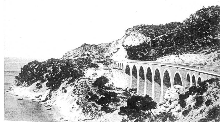
Viaduc de la Corbière
